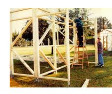
UNA VEZ ARMADA LA ESTRUCTURA, CON TODOS LOS MODULOS FIJADOS, SE UBICA UN DINTEL DE 2"x4" SOBRE EL TRAVESAÑO SUPERIOR EN TODO EL PERIMETRO DE LA VIVIENDA Y EN LAS PAREDES DE DIVISION INTERIORES.
